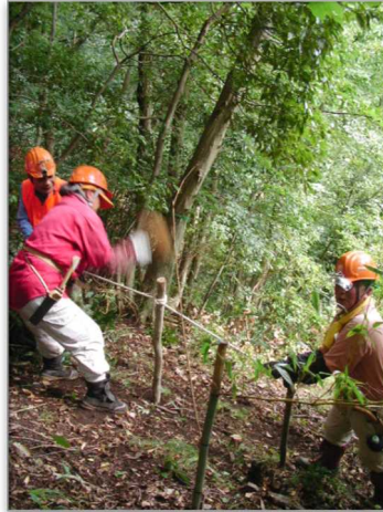
ロープと掛矢(カケヤ)を使って杭を打ち込む
