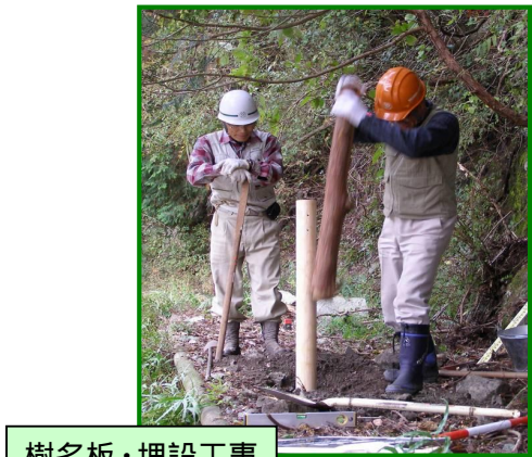
樹名板・埋設工事
