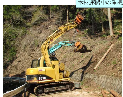
木材運搬中の重機
