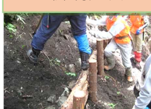
杭打ち、番線縛り/締めの写真なし 上記終了後の土入れ
