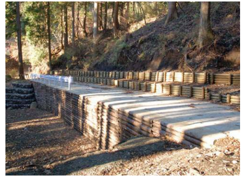
③外壁の内側に土を埋め、コンクリートで舗装して周遊歩道が完成。
