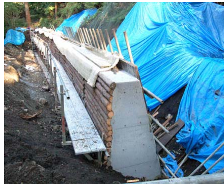
②外側の型枠と内側の型枠の間にコンクリートを流し込み外壁が完成。
