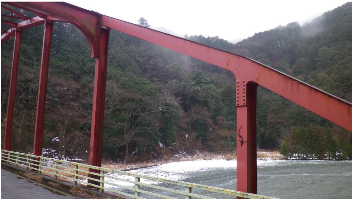
水源の森の入り口の寄大橋。対岸には雪が残ってます
