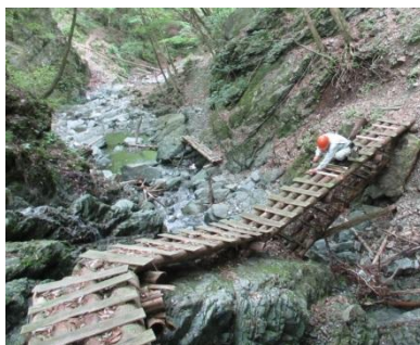
橋の補修で安全確保
