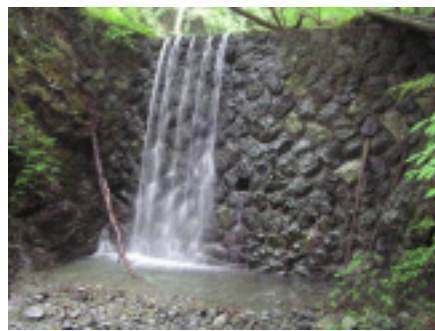
石積みの堰堤。往時の匠の技です。
