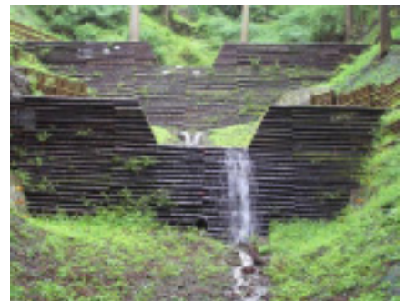
間伐材を型枠に利用した最近の堰堤
