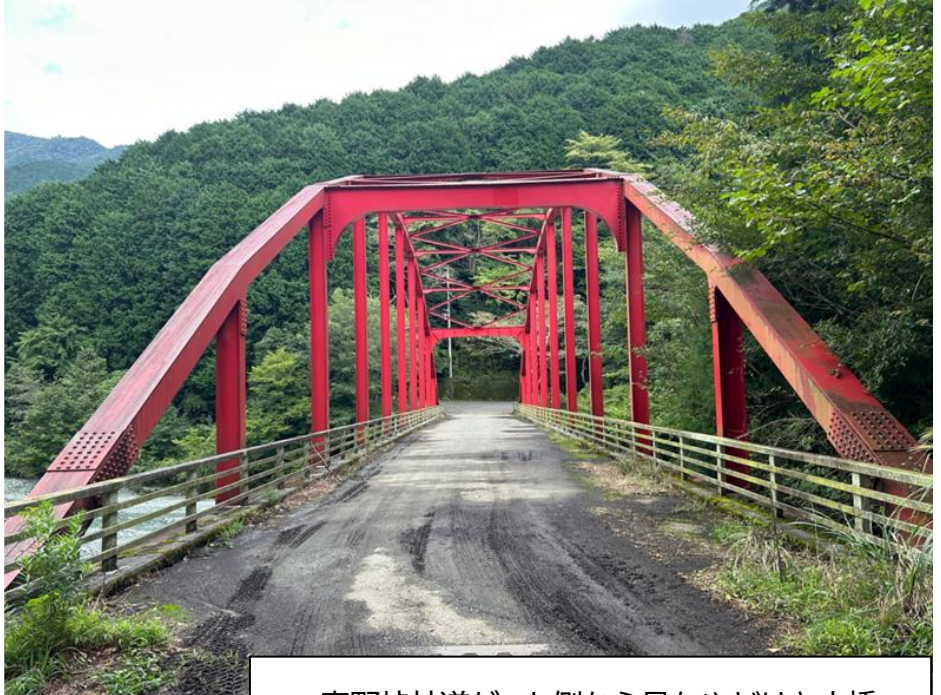
秦野峠林道ゲート側から見たやどりき大橋
